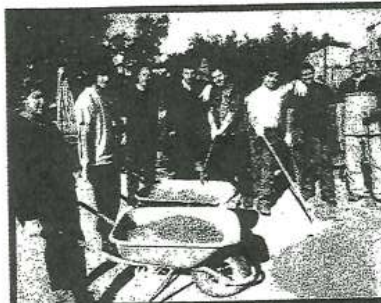
Le chantier prend fin lundi, après 7 jours de travail
